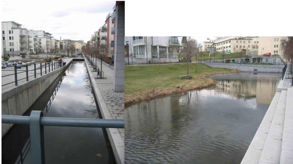
Figur 9: Kanal samt damm för dagvatten från Hammarby Sjöstad.
